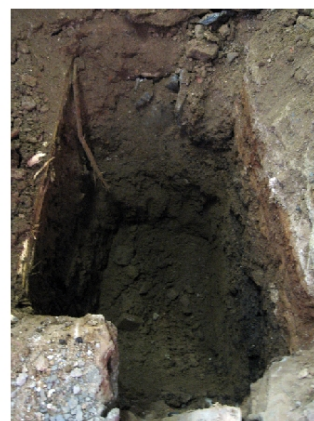
05 - Rebaix Sondage 1 Final.jpg
