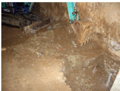
01 - Inici Rebaix Rasa 1.jpg
